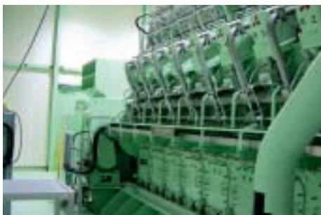
富士製造所で、「リーンバーン天然ガスコージェネレーションシステム」を稼働しました。( P23)
